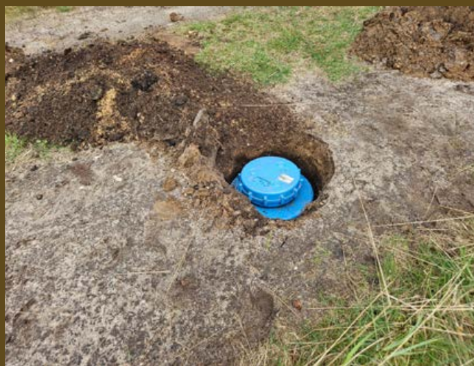
Mijn geplaatst, onderzijde gat vlak ipv conisch door scheppen.
