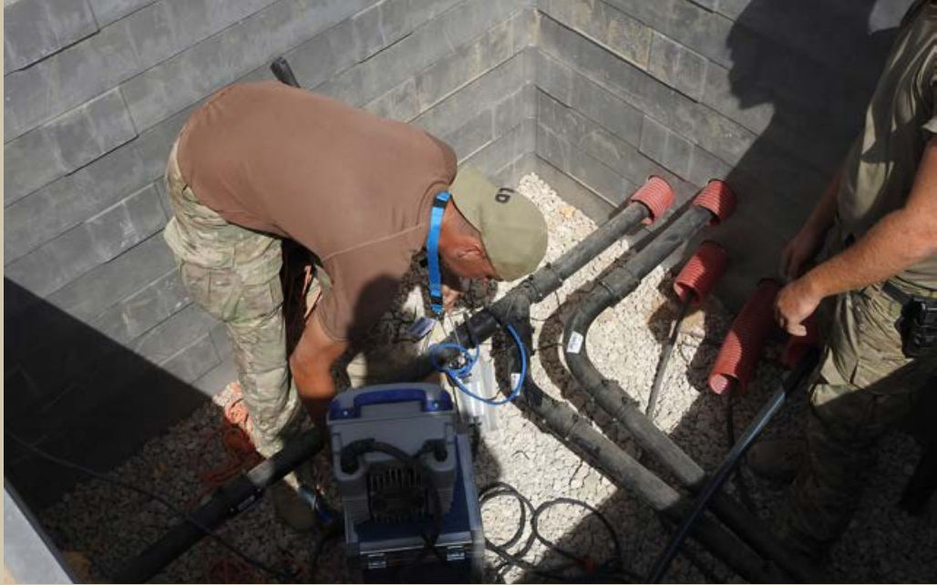
Aansluiten drukriolering, Mazar-E-Sharraf, Afghanistan 2018.
