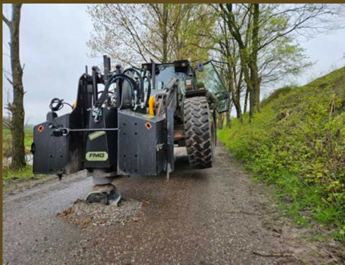
Gat boren in wegdek.
