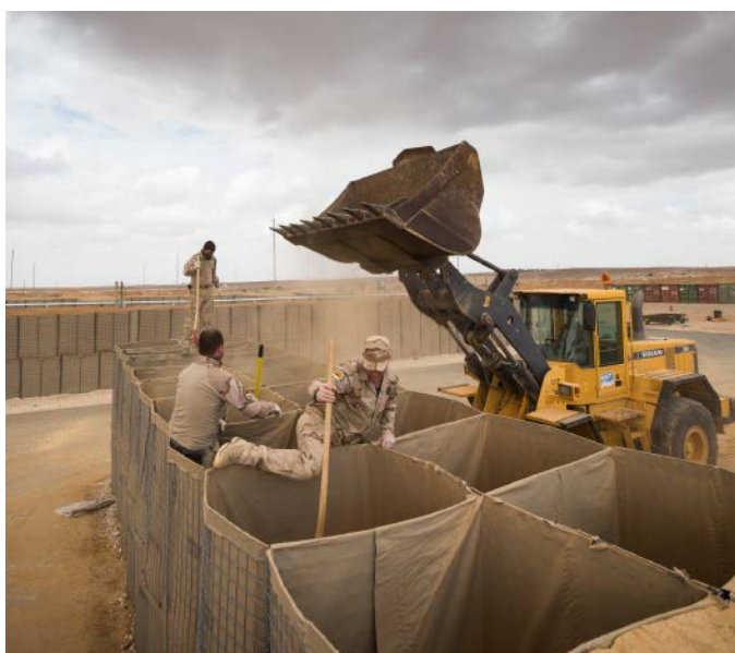
De nieuw geplaatste Hesco vullen.
