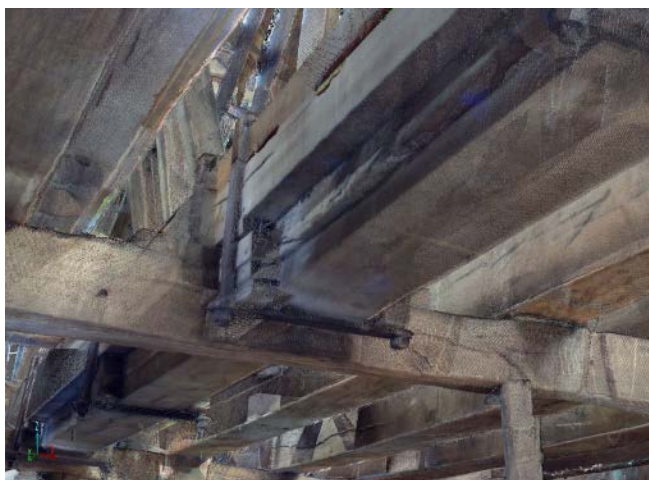
3D opname van de onderzijde van een brug (Leap 3D)
