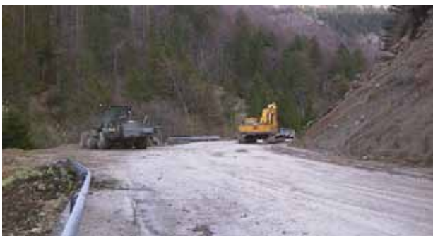
Wegherstel met bouwmaschinen in Bosnië
