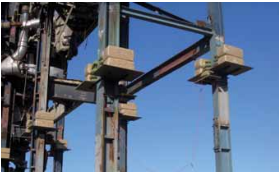
16 snijladingen en 8 drukladingen geplaatst
