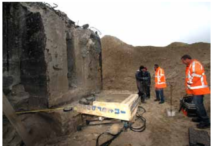
Het zagen van de bunker
