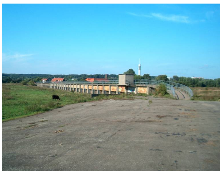
4.14. Locatie 8. Overstortdijk met doorlaatsluis, 2005. (Herkomst: SB4 .)
