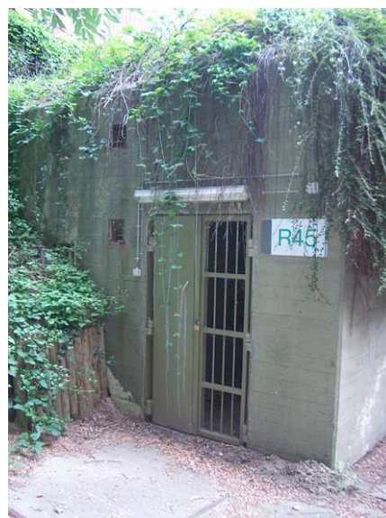
4.20. Locatie 10. Entree bataljons-commandobunker, 2005. (Herkomst: SB4 .)
