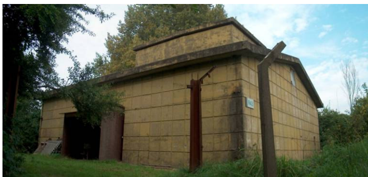
4.18. Locatie 9. Commandobunker luchtverdediging, 2005. (Herkomst: SB4 .)
