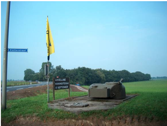
3.5. Tankkazemat in de vorm van een ingebetonneerde Sherman tank, situatie bij Olst, 2005. (Herkomst: SB4.)
