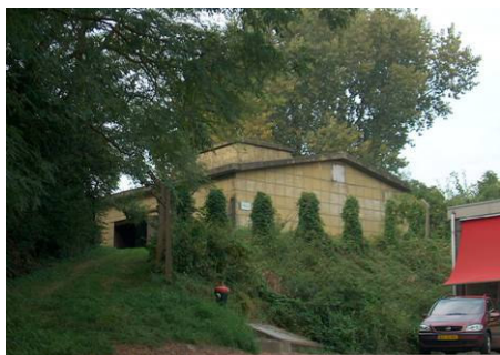
4.17. Locatie 9. Commandobunker luchtverdediging, 2005. (Herkomst: SB4 .)
