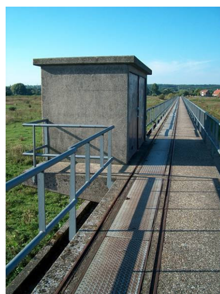
4.16. Locatie 8. Brug over doorlaatsluis, 2005. (Herkomst: SB4 .)
